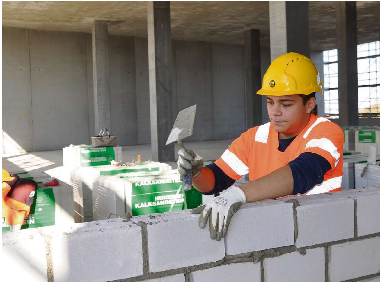
«Die Arbeit macht Spass und geht mir darum leicht von der Hand.» Fabio Melillo auf der aktuellen Baustelle in Muttenz.
