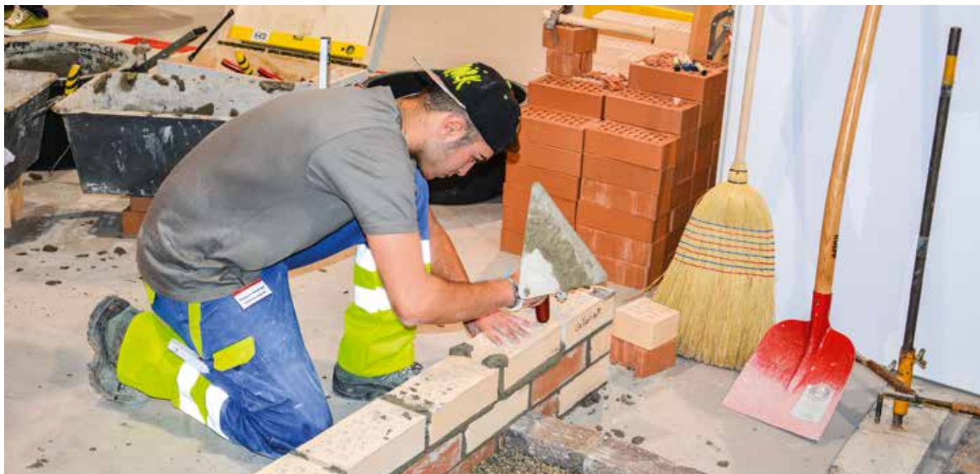
Gianluca Carmollingo demonstriert, wie präziser Mauerbau entsteht und aussehen muss.
